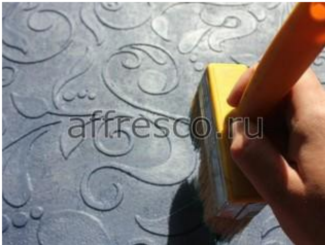
Покраска фона основным тоном при помощи широкой кисти.
