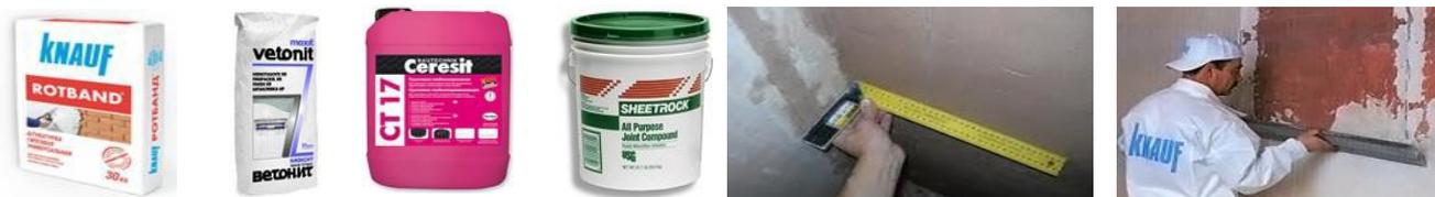
Потом прошпатлевать акриловой шпатлёвкой, «Ветонитом», или, если стены склонны к влажности, антисептической шпатлёвкой на основе ПВА или иными, имеющими в составе антисептик. Высушить. Отшлифовать и вновь нанести двойной слой грунтовки. Стена готова. Если у ваших стен нет трещин или сколов, и стены имеют ровную поверхность, достаточно будет грунтовки и шпатлёвки на ваш выбор.
